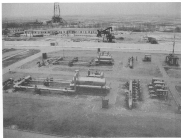
图 1 集气站橇装模块化设计布置图
