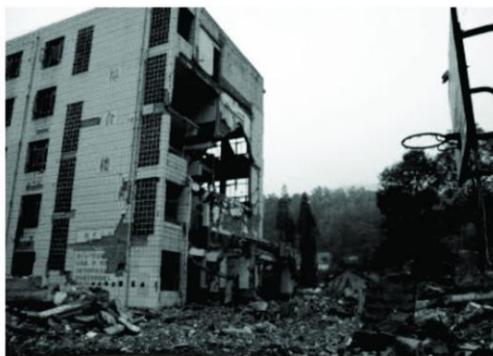
图1 某中学教学楼右段砖混结构倒塌(左段为框架结构)
