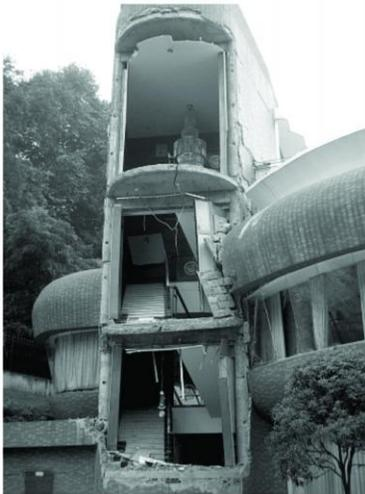
图 13 楼梯间弧形砌体填充墙完全倒塌
