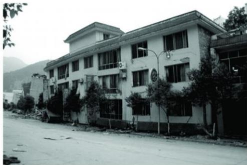
图 7 底框部分完全被压垮
