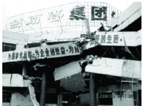
图 6 框架—砖混办公楼(水平混合)破坏
