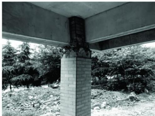
图 16 柱头破坏, 梁板完好
