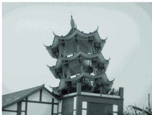
图 19 屋顶塔楼破坏
