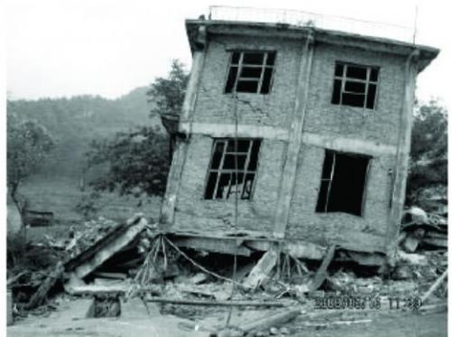
图 5 底框砖混结构破坏
