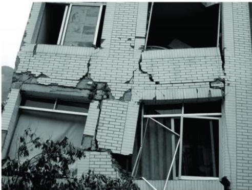
图 4 如果没有构造柱和圈梁,房屋恐怕已倒塌
