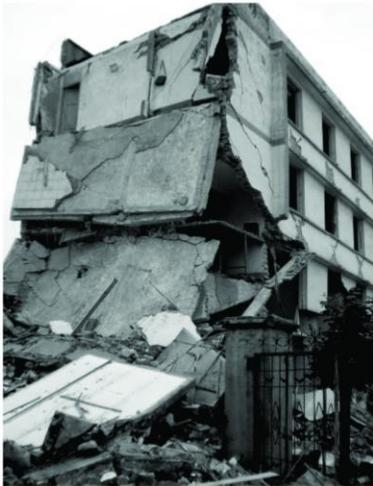
图 3 某砖混结构住宅楼端开间倒塌
