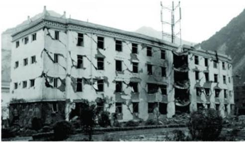
图 2 某中学宿舍楼,五层砖混结构,地震时底层完全倒塌上部墙体开裂破坏严重
