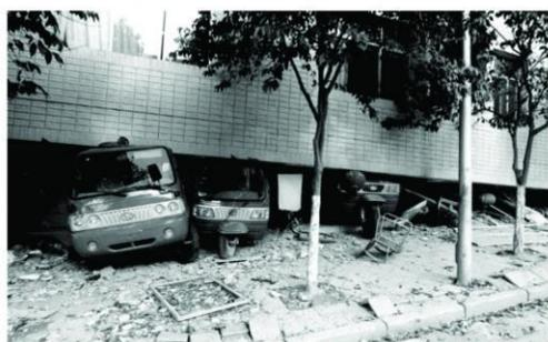
图 8 底框部分完全破坏
