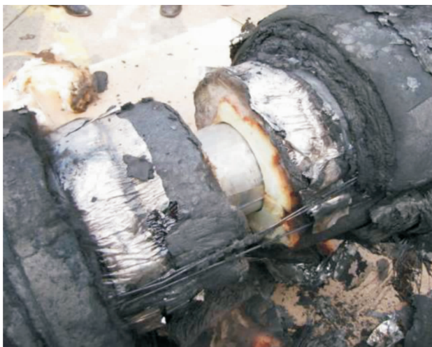
图2 燃烧试验后的保冷结构
