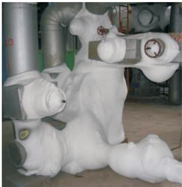
图 4 阀门表面结冰
