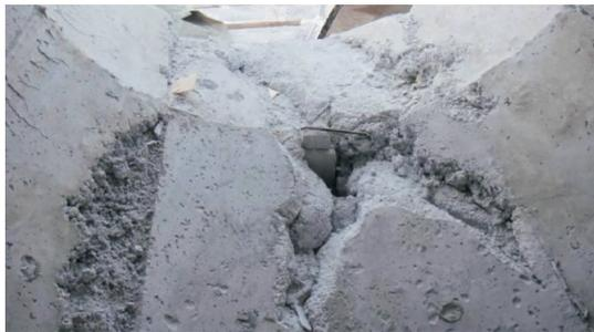
图 2 目测重质料品牌一拆模后表面质量
