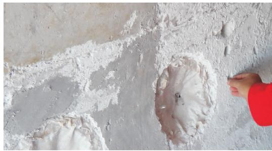
图 3 品牌一拆模后用手就可剥落
