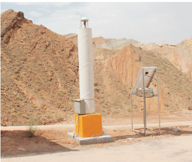
图 4 隧道洞口 GPS 参考站
