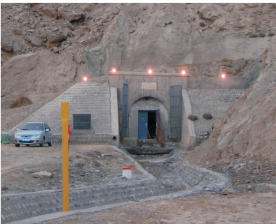
图 5 隧道洞口监测点
