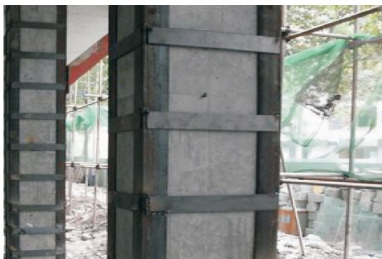
图 5 外粘角钢加固后第一层柱子 (抹灰前)
