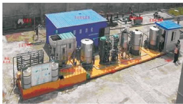
图 3 滨南稠油首站试验现场
