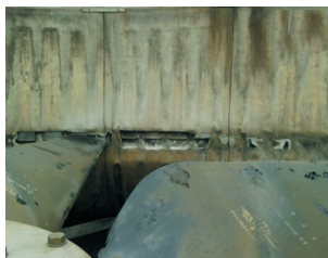
a) 风筒内部破损
