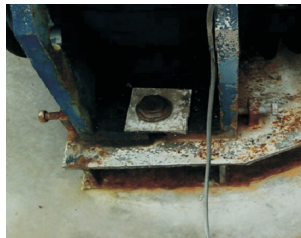
c) 设备腐蚀
