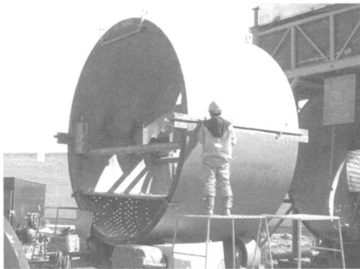
图 4 防止变形加固图
