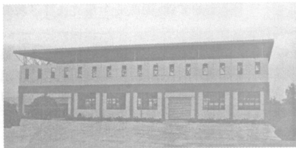
图 8 综合库房及发配电房主体立面外观
