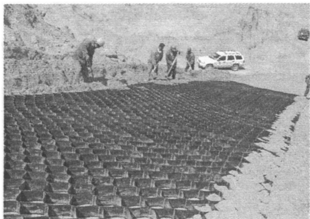
图 2 土工格室施工现场
