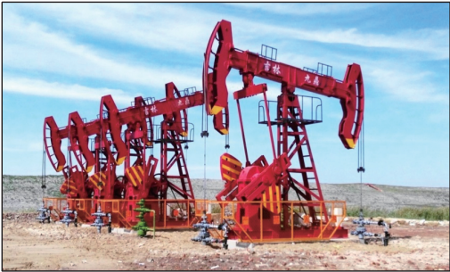
图 3 双驴头抽油机现场图
