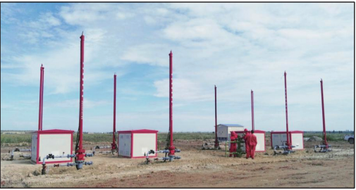
图 4 液压抽油机现场图
