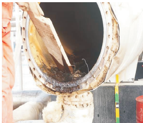
图 3 壳程内清出的泥砂和盐照片
