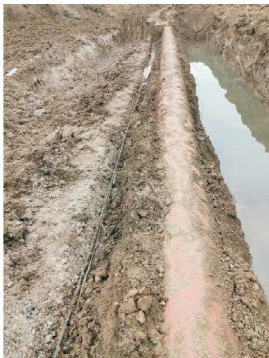
图2 管道和光缆同沟敷设照片
