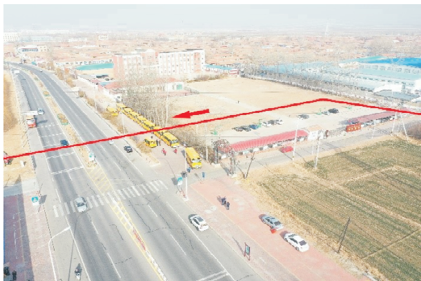
图2 管道周边情况航拍图
