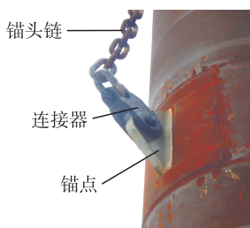
图 3 吸力锚、锚点、锚头链和连接器图
